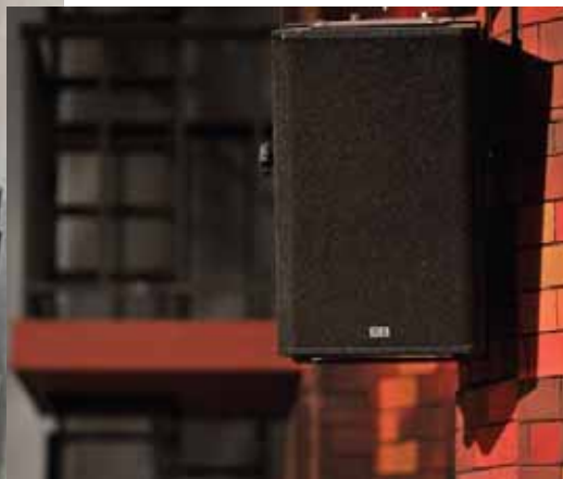
O PA instalado no Politeama é da marca alemã KS e conta com colunas T4 e CL-106. O sistema foi fornecido em 2003 pela NAN e montado pela própria KS, continuando a responder bem às condições da sala
